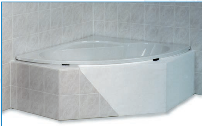
Eckwannenträger kurz vor Abschluß der Verfliesung
